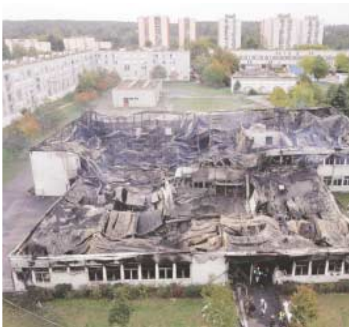
Le collège Val-d'Huisne, construit dans les années 1970, était de type «Pailleron».
